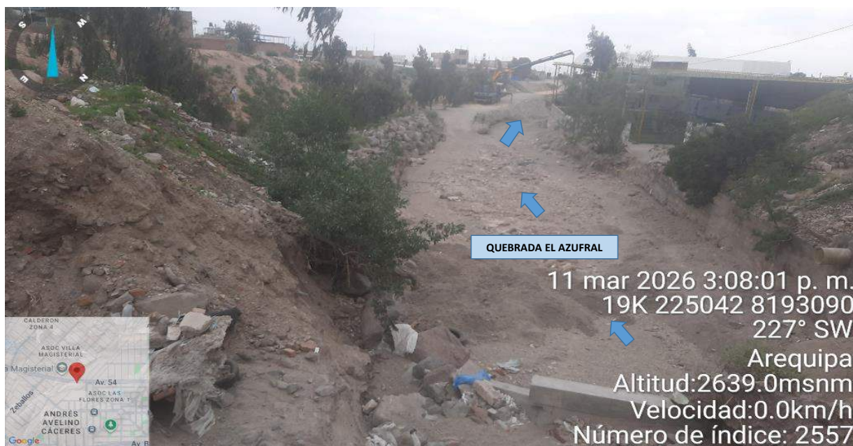
IMAGEN 02: EN ESTE TRAMO SE OBSERVA QUE EN LA MARGEN DERECHA DE LA QUEBRADA EL AZUFRAL, SE ENCUENTRA UN MURO DE CONCRETO, EN MAL ESTADO, Y EN LA MARGEN IZQUIERDA, SUS TALÚDES SE ENCUENTRAN DEBILITADOS, SIN PROTECCIÓN Y SU CAUCE SE ENCUENTRA COLMATADO.
